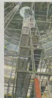
Steil nach oben (oder unten) führt das Gerüst in der Kirche. Fotos: BKH
