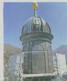
Von oben bis unten wird die vor 1700 erbaute Kirche saniert. Die Expertise, vor allem von Salzburger Unternehmen, ermöglicht das.
